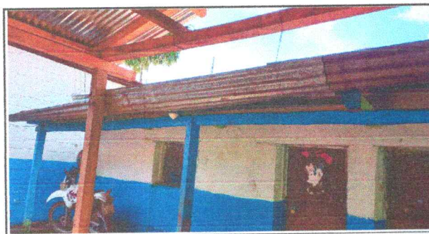
Foto 5: cambio de bajadas de agua y canales
