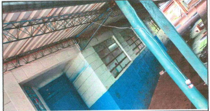
Foto 8: Reparación de sistema eléctrico
