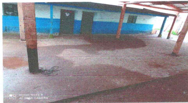
Foto 4: Sustitucion de plancha de concreto de patio
