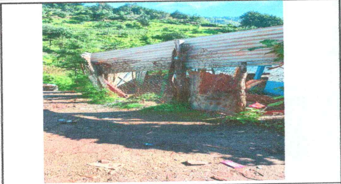
Foto7: Reparacion de tubo y malla galvanizada
