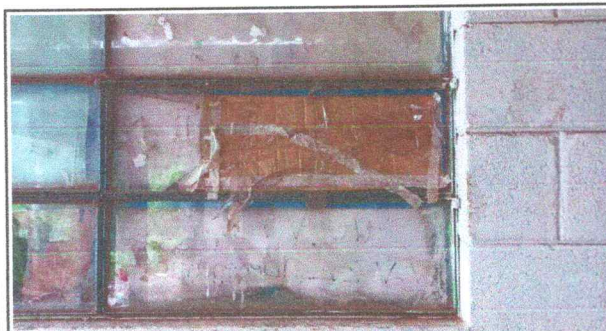
Foto 3: cambio de vidrios en ventanales.
