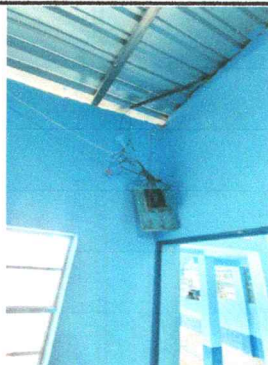
FOTO 15: SUSTITUCION DE TABLEROS DE FLIPONES
