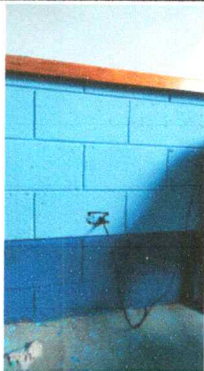
FOTO 13: SUSTITUCION DE TOMACORRIENTES DOBLES
