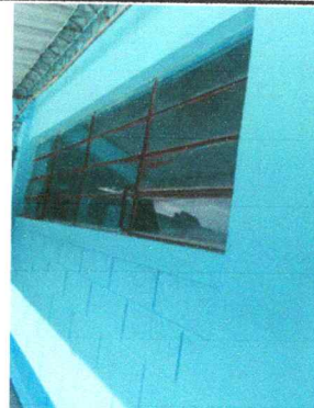
FOTO 4: MANTENIMIENTO A ESTRUCTURA DE METAL DE VENTANA
