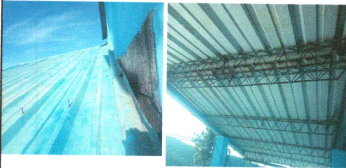
FOTO 1: SUSTITUCION DE LAMINA POR LAMINA TROQUELADA ALUNZINC CALIBRE 26 EN AULA Y ESPACIO DE GRADAS
