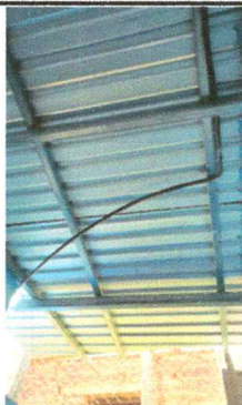
FOTO 17: SUSTITUCION DE DUCTO ELECTRICO MAS ACCESORIOS
