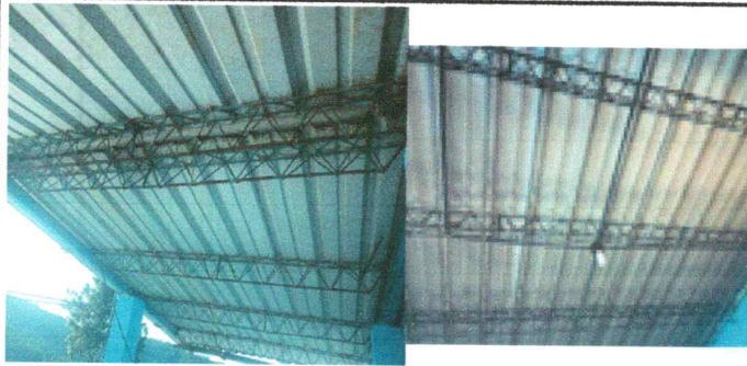
FOTO 3: SUSTITUCION DE ESTRUCTURA DE SOPORTE DE METAL POR METAL EN AULA Y ESPACIO DE GRADAS
