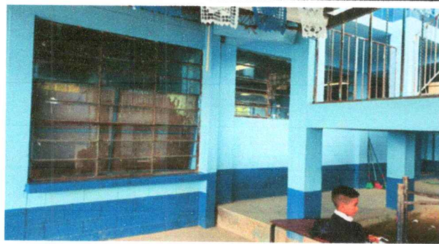
FOTO 5: MEJORAMIENTO DE BALCONES
