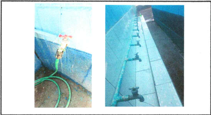
FOTO 9: SUSTITUCION DE CHORROS
