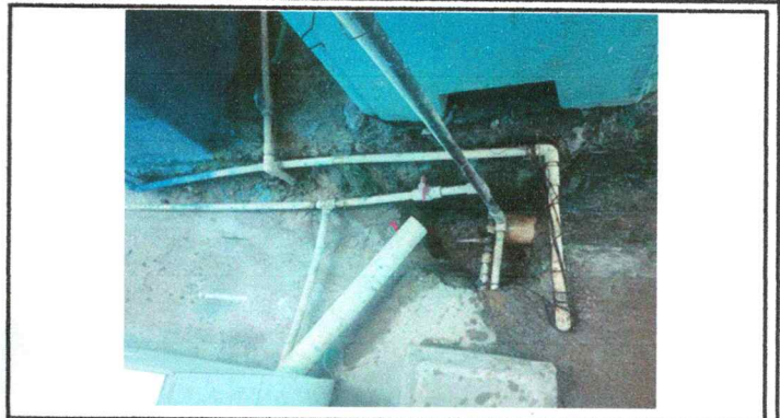
FOTO 8: SUSTITUCION DE TUBERIA LINEA PRINCIPAL
