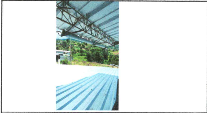
FOTO 7: SUSTITUCION DE CANAL DE METAL POR PVC
