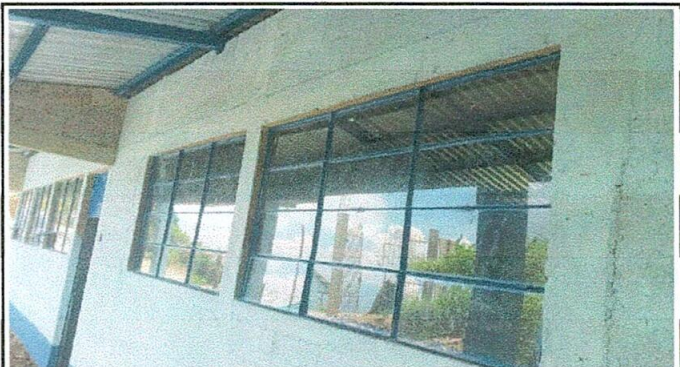
FOTO 3: Sustitución de estructura de metal de ventanas con vidreos
