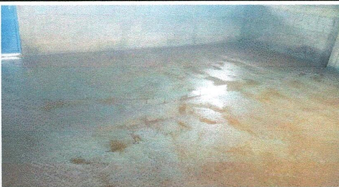
FOTO 9: Sustrucion de torta de cemento
