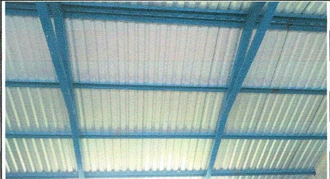
FOTO 2: Sustitución de estructura de soporte y mejoramiento de pared y soporte de mojinete del techo
