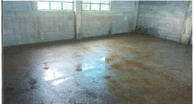
FOTO 8: Sustrucion de torta de cemento
