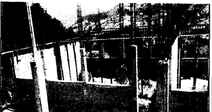
FOTO 4: Sustrucción de canal de metal y sustitución de bajada de agua pluvial tubo PVC 4"
