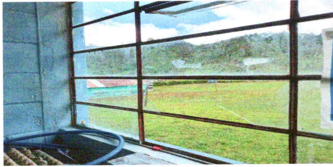
Foto7: sustitucion de vidrios
