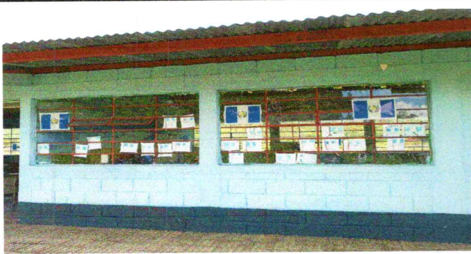
Foto 9: Mejoramiento de balcones de metal
