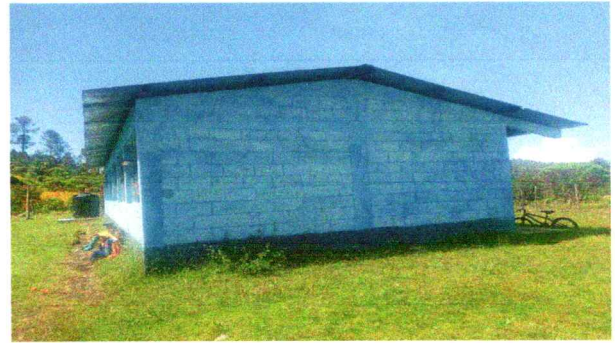
Foto 10: pintura en muros exteriores e interiores
