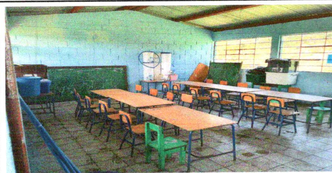
Foto 11: Pintura en muros exteriores e interiores
