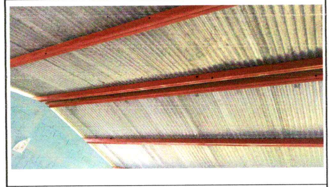
Foto 4: Mantenimiento a estructura de soporte de metal
