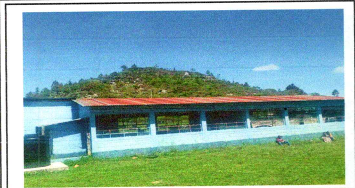
Foto 1: sustitucion de lámina por lámina troquelada calibre 26, Sustitución de capote de lámina para lámina troquelada, Sustitucion de elementos de fijacion
