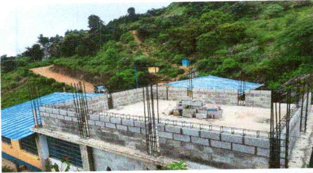
Foto1: MEJORAMIENTO DE LAMINA, POR LAMINA TROQUELADA, ALUZINC, CALIBRE 26, MEJORAMIENTO DE ESTRUCTURA POR SOPORTE DE METAL, MEJORAMIENTO DE PUERTA Y VENTANA DE ESTRUCTURA DE METAL Y VIDRIO
