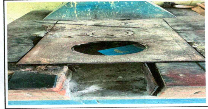
Foto 12: Sustitución de plancha de metal de 3 hornillas
