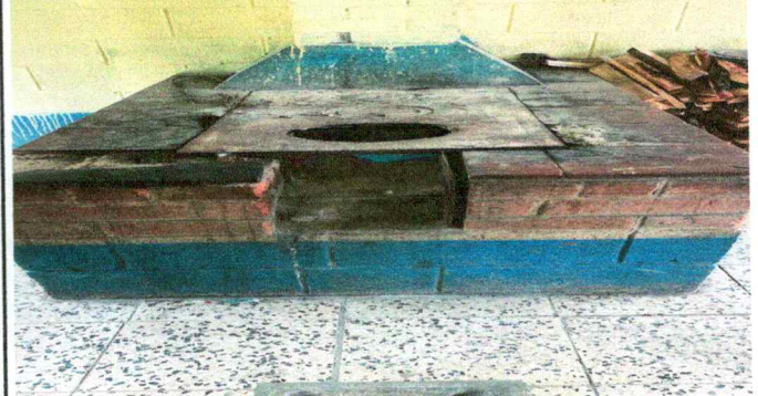
Foto 14: Sustitución de azulejo en estufa rural
