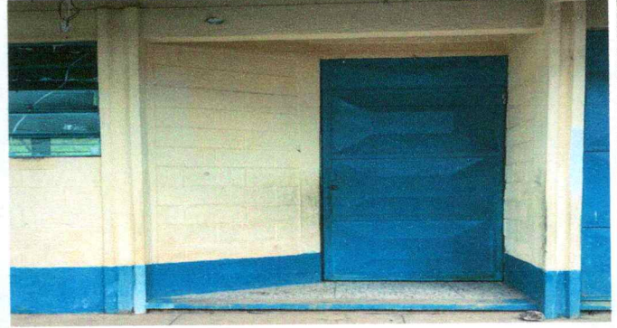
Foto 2: Sustitución de puerta de metal
