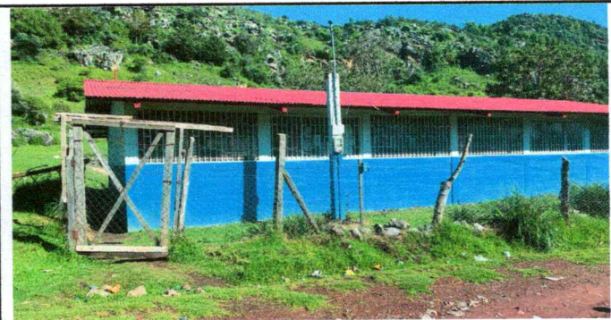
Foto 4: Sustitución de porton de metal
