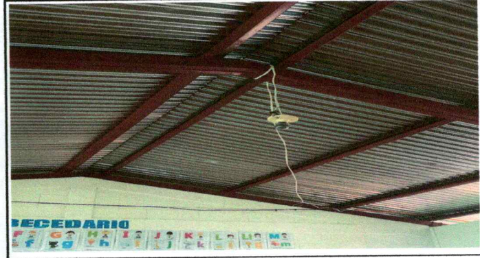
Foto 10: Sustitución de ducto eléctrico mas accesorios
