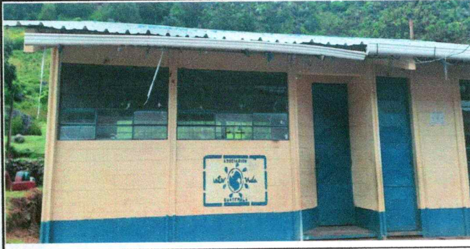
Foto 6: Sustitución de canal de metal
