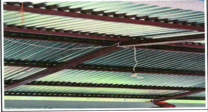
Foto 8: Reparación de cableado eléctrico
