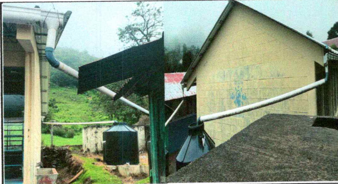
Foto 7: Mejoramiento de bajadas de agua pluvial de metal
