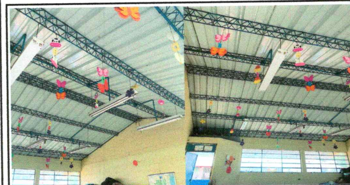
Foto 11: Sustitución de reflectores led de 100 wats
