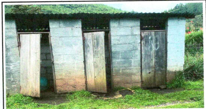
Foto 16: Sustitución de puerta de metal de baños
