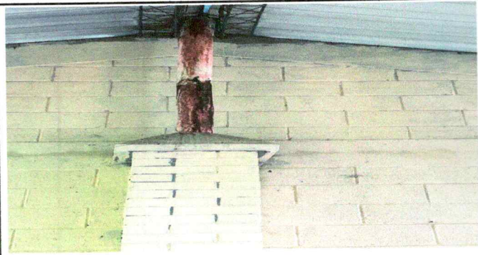
Foto 13: Sustitución de chimenea de metal
