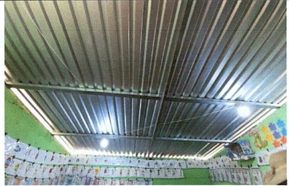
Foto 4: REPARACIÓN DE SISTEMA ELÉCTRICO
