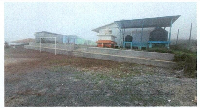
Foto 6: LOSA DE PATIO
