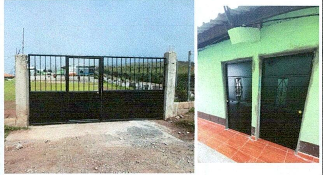
Foto 2: PUERTAS Y PORTÓN DE METAL
