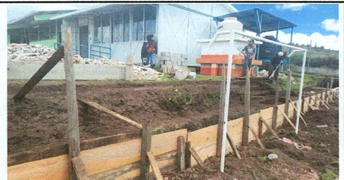
Foto 6: LOSA DE PATIO
