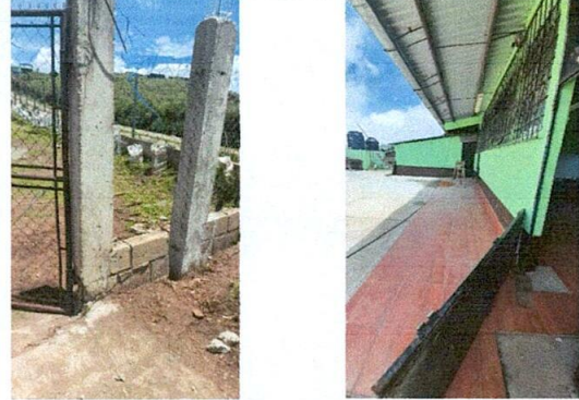
Foto 2: PUERTAS Y PORTÓN DE METAL
