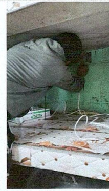
Foto 4: REPARACIÓN DE SISTEMA ELECTRICO
