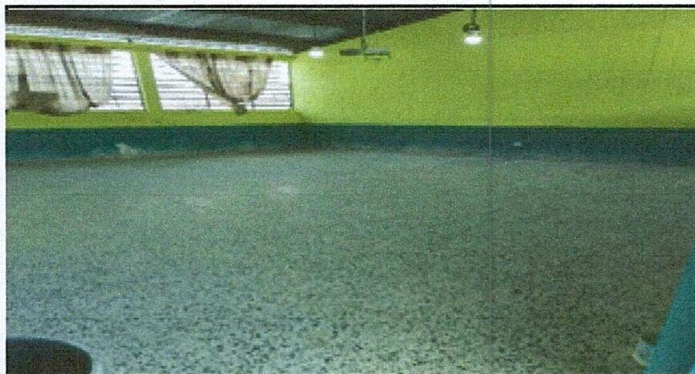
Foto 5: Aula Primero B Instalación de piso granito finalizado
