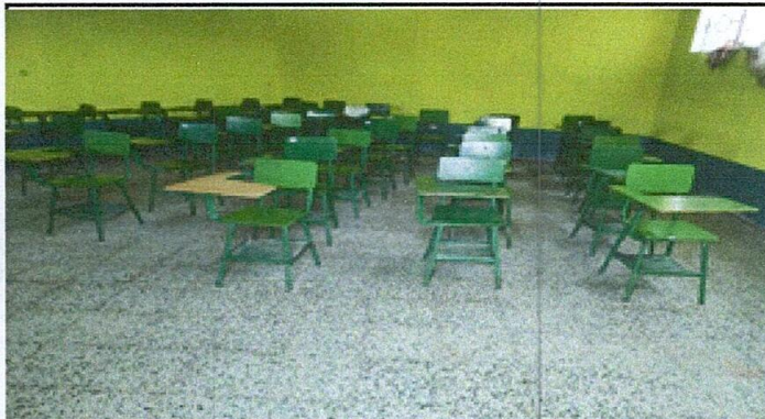
Foto 3: Aula Tercero "C". Instalación de Piso finalizado
