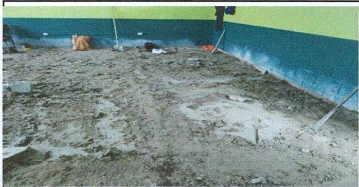
Foto 6: Fotografía de aula de primero levantndo piso de cemento para la insltación de piso granito.
