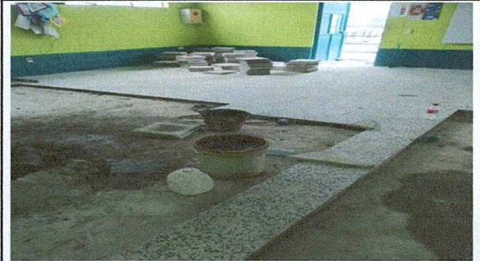
Foto 2: Fotografía correspondiente a Aula 2, tercero B Avance en la instalación de piso granito
