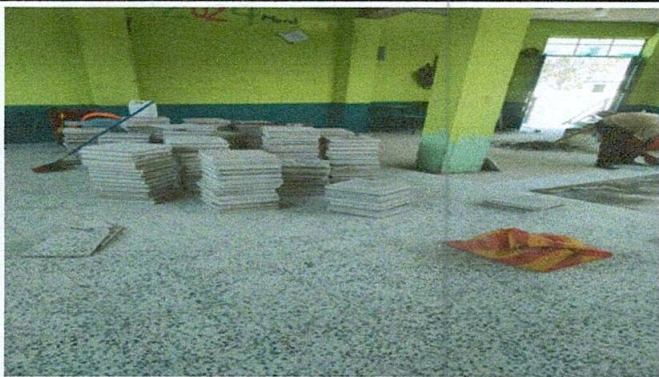
Foto 3: fotografía de aula tercero B finalizando la instalación de piso granito.
