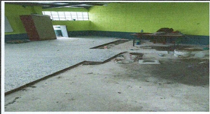
Foto 4: Fotografía de aula 3, tercero C, instalando piso granito
