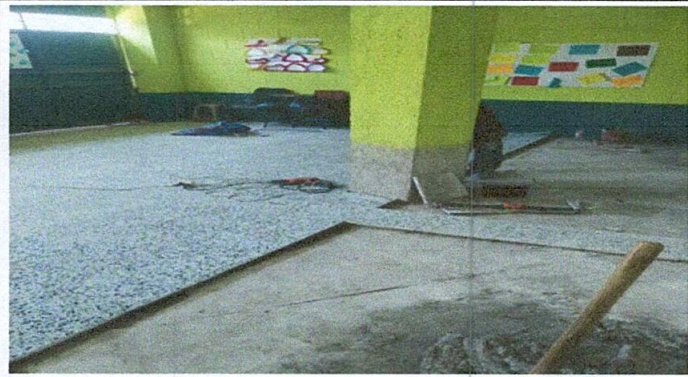
Foto 1: Fotografía correspondiente a aula 1, tercero A. instalando piso granito
