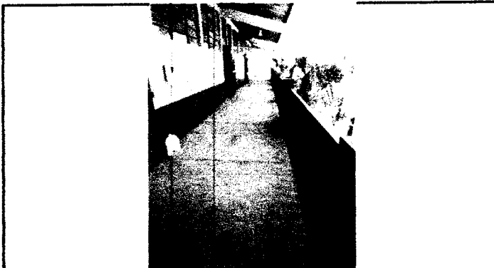
CORREDOR UBICADO EN EL SEGUNDO NIVEL A REMOZAR PISO DE CONCRETO POR PISO GRANITO.
