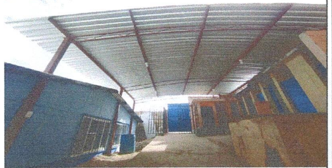
Foto 4. Complemento de techo de patio
