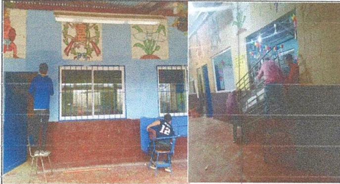
Foto 1, sustitución de ventanas de hierro por PVC , aplicación pintura en interior y exterior
