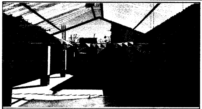
Foto. 2 sustitución de techo, lámina por lámina
