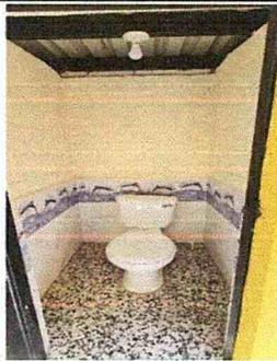
Foto 3: Sustitución de piso de concreto por piso granito
