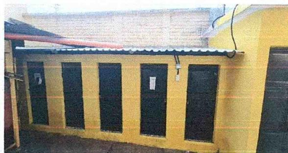
Foto 2: Sustitución de lámina, por lámina troquelada aluzinc caliobre 26
