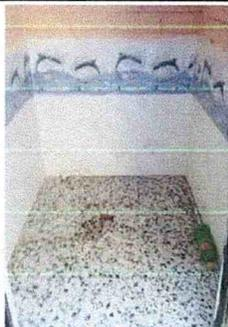
Foto 3: Sustitución de piso de concreto por piso granito
