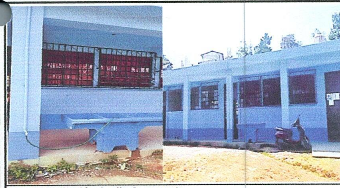
Foto 5: Sustitución de pila de concreto.
