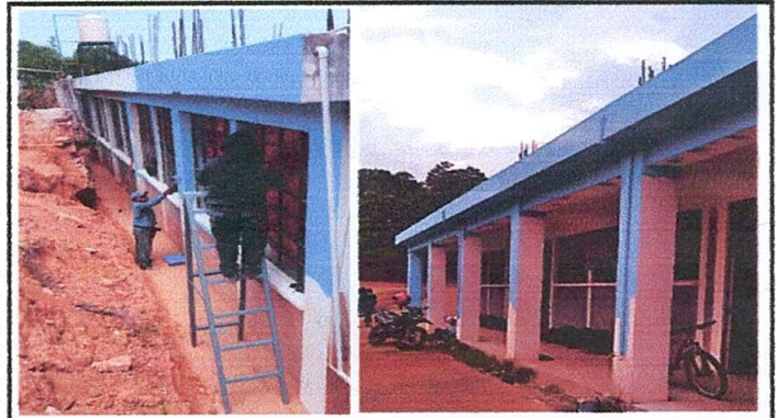
Foto 4: Pintura en muros exteriores e interiores.
