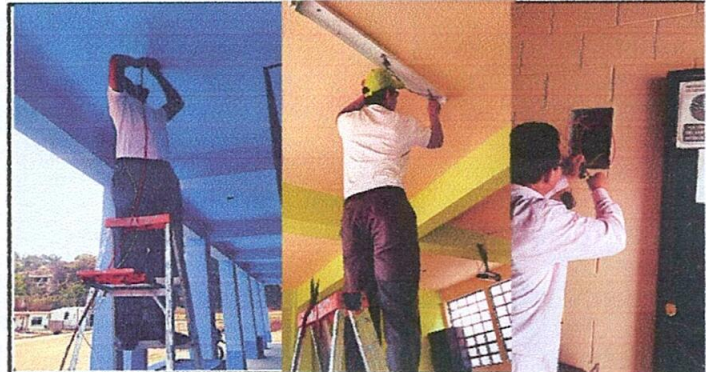
Foto 6: Reparación de sistema eléctrico
