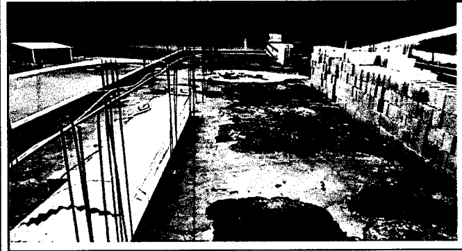
Foto1: Impermeabilización de losa
