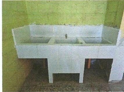
Foto 2: Reparación de pila de cemento de dos lavaderos
