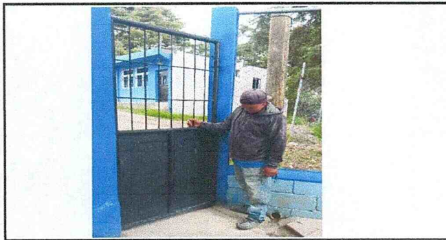
Foto 5: Mejoramiento de puerta.
