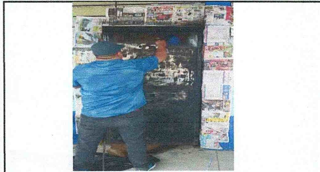
Foto1: Mantenimiento de puertas.
