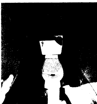
Foto 3: Inodoros en mal estado
