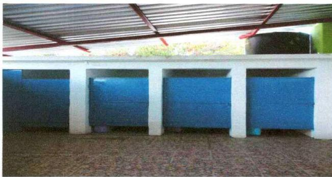
Foto 7: Sustitución de losa por piso cerámico antideslizante en área de servicios sanitario
