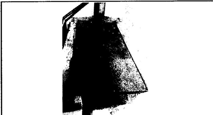
Foto 3: Es necesario cambiar la estufa artesanal ya que por filtración de agua de lluvia se deterioró presentando oxidación.
