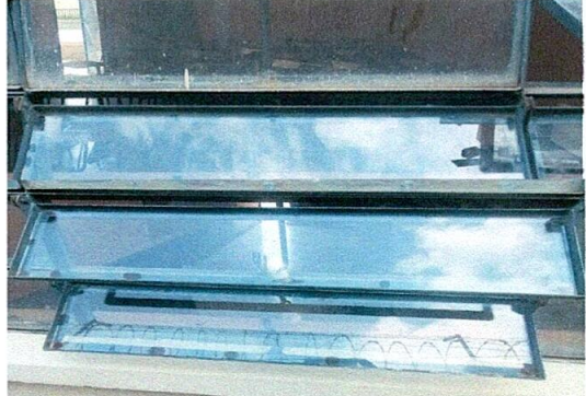
Foto 2: sustitución de vidrios.
