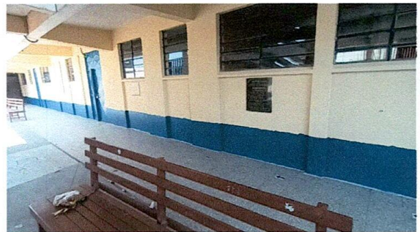
Foto 10: Aplicación de pintura de agua y aceite a paredes interior
