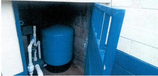
Foto7: Reparación de bomba de agua más accesorios
