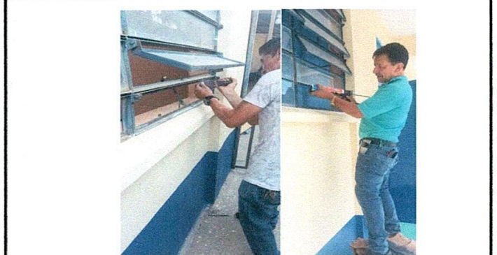
Foto 2: sustitución de vidrios.
