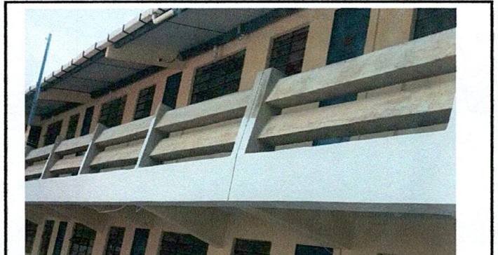
Foto 4: Mantenimiento a barandas de metal y de concreto.
