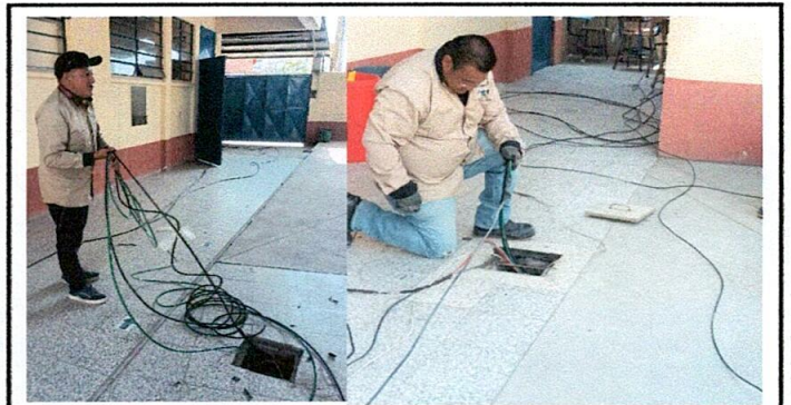
Foto 6: Reparación de cableado eléctrico
