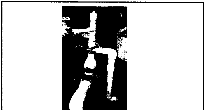
Foto 4: Reparación de bomba de agua
