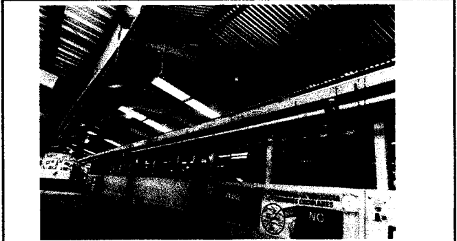
FOTO 2: CANALES EN MAL ESTADO
