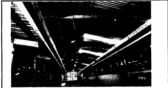
FOTO 1: TECHADO DE SALON DE LAMINAS
