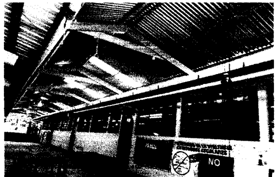
FOTO 2: CANALES EN MAL ESTADO
