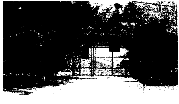
FOTO 4: PUERTA DE METAL DE LA ENTRADA.
