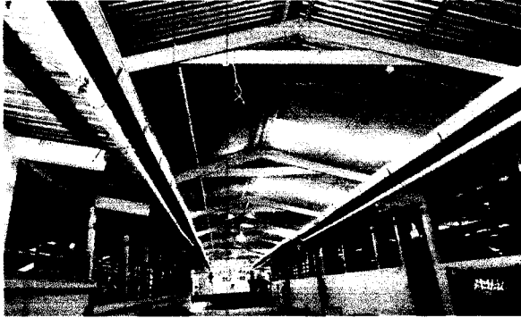
FOTO 1: TECHADO DE SALON DE LAMINAS
