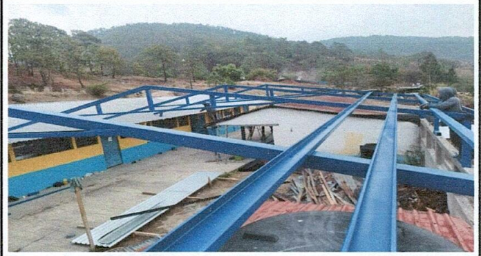
Foto 2: Cambio de Estructura de techo
