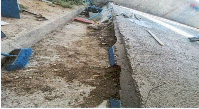
Foto 1: Cambio de Planchas de cemento
