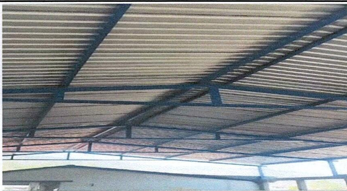
Foto 3: Cambio de láminas
