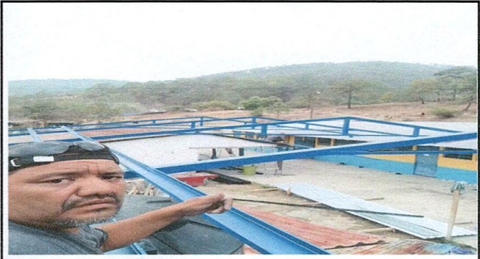
Foto 4: Cambio de Costaneras
