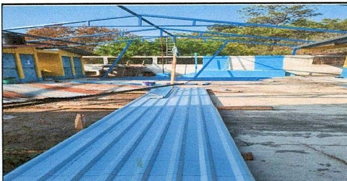
Foto 6: Levantado de estructura de metal
