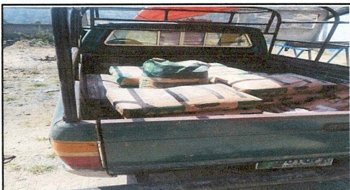
Foto 3: Ingreso de material al centro educativo
