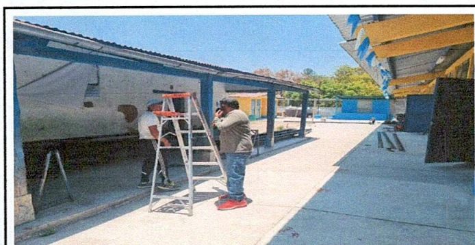
Foto 5: Desmontado de estructura antigua y láminas antiguas
