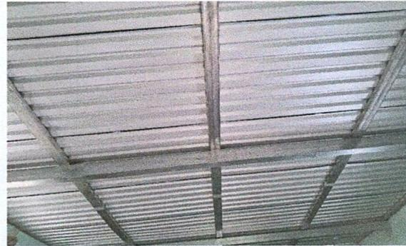
Foto 2: Sustitución de estructura de madera por metal
