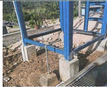
Foto 6: Reforzamiento con concreto de la base de metal para cisterna de agua
