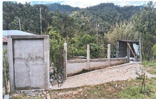
Foto 4: Sustitución de lamina y malla por block
