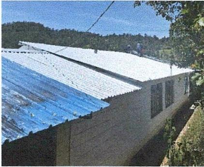
Foto1: Sustitución de lamina por lamina troquelada
