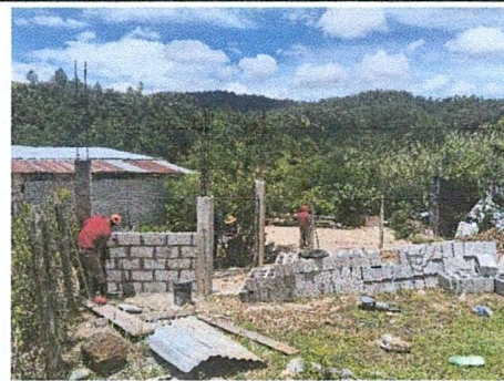
Foto 4: Sustitución de lamina y malla por block
