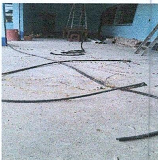
Foto 5: Reparación del sistema eléctrico
