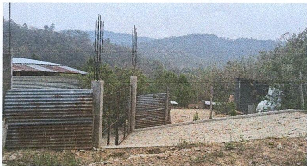
Foto 4: Sustitución de lamina y malla por block
