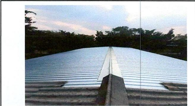
Foto1: SUSTITUCIÓN DE TECHO TIPO TEJA POR LAMINA TROQUELADA
