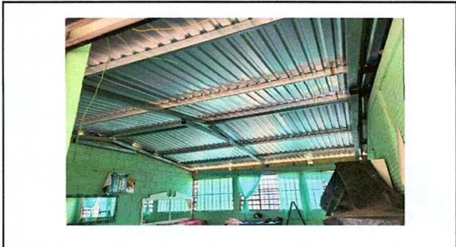
Foto 2: SUSTITUCIÓN DE TECHO TIPO TEJA POR LAMINA TROQUELADA
