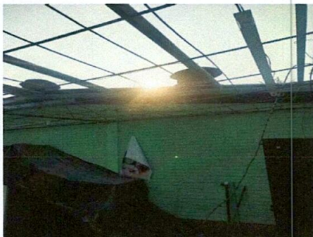
Foto 5: SUSTITUCIÓN DE ELEMENTOS DE FIJACIÓN, CAMBIO DE CIELO FALSO
