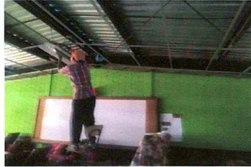
Foto 8: SUSTITUCIÓN DE ELEMENTOS DE FIJACIÓN, CAMBIO DE CIELO FALSO
