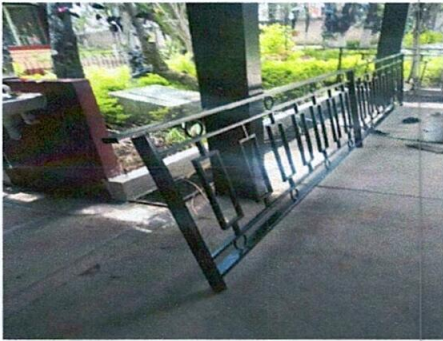
Foto 3: SUSTITUCIÓN DE ELEMENTOS DE FIJACIÓN DESMONTAJE DE REJA REAL
