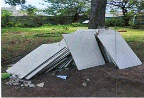
Foto 7: SUSTITUCIÓN DE ELEMENTOS DE FIJACIÓN, CAMBIO DE CIELO FALSO
