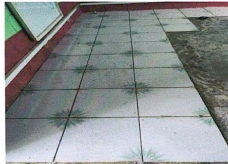
Foto 10: SUSTITUCIÓN DE ELEMENTOS DE FIJACIÓN CAMBIO DE PISO
