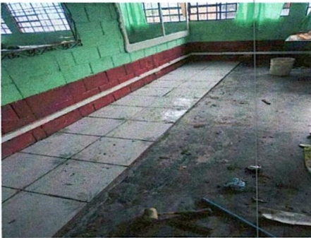
Foto 9: SUSTITUCIÓN DE ELEMENTOS DE FIJACIÓN CAMBIO DE PISO
