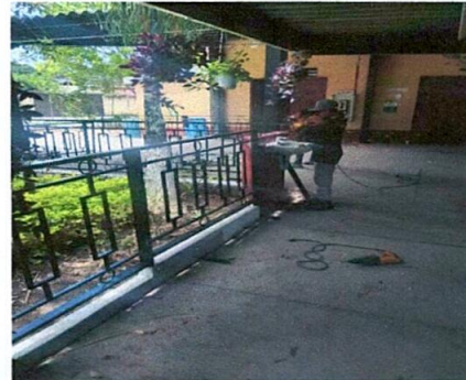
Foto 4: SUSTITUCIÓN DE ELEMENTOS DE FIJACIÓN DESMONTAJE DE REJA REAL
