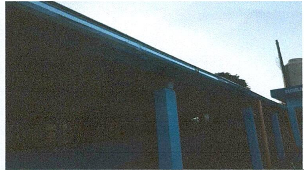
Foto 6: canales de agua instalados
