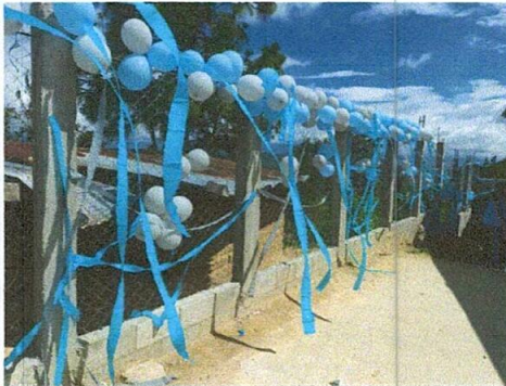
Foto 3: Muro perimetral lado este terminado
