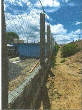
Foto 1: muro perimetral norte construido
