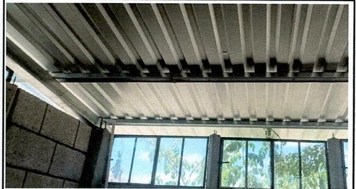
Foto 2: colocación de estructura de soporte de metal galvanizada en cocina y aula.
