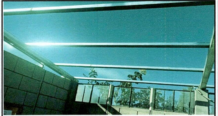
Foto 2: colocación de estructura de soporte de metal galvanizada en cocina aula.
