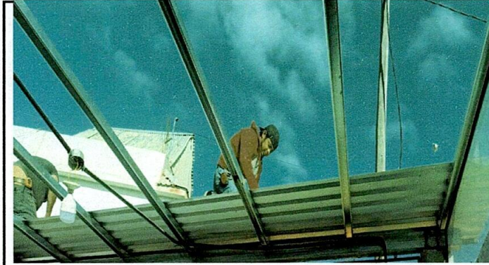
Foto1: colocación de laminas troqueladas aluzinc calibre 26 en cocina y aula.
