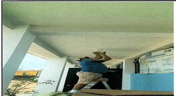
Foto 4: colocación de focos ahorradores tipo led.
