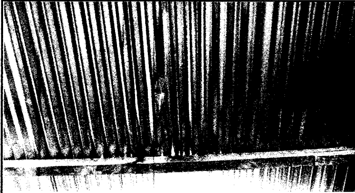
Foto 1: Laminas de cocina y aula en malas condiciones la cual será sustituida por lamina troquelada aluzinc calibre 26.
