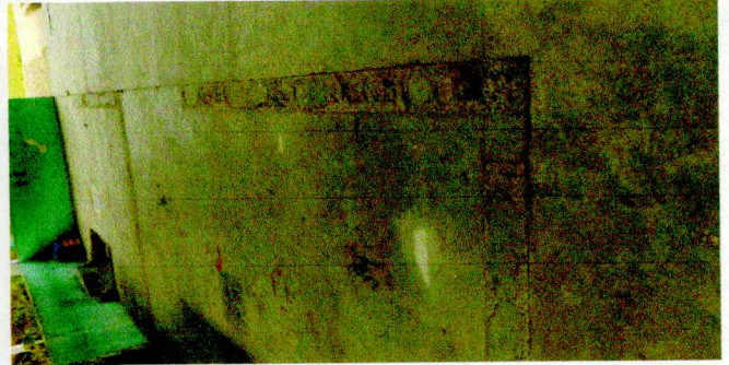
Foto 8: Sustrucción de torta de cemento, por piso granito.
