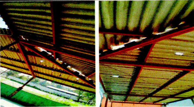
Foto 3: Mantenimiento de estructura de soporte de metal
