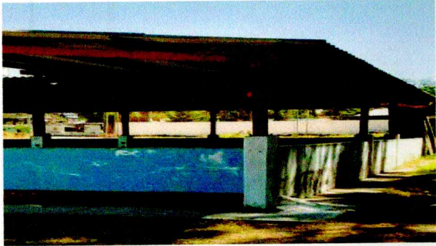
Foto1: Mejoramiento de Paredes.
