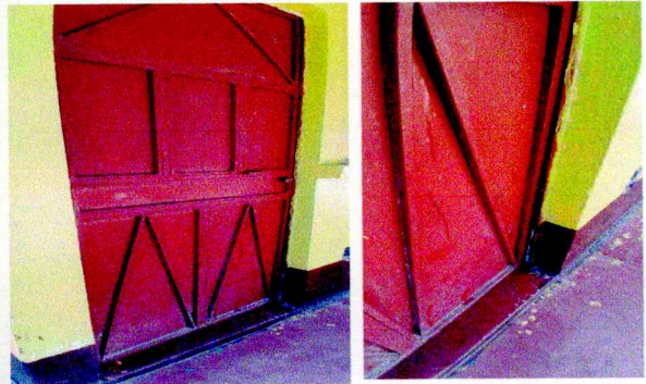
Foto 4: Sustitucion de puertas
