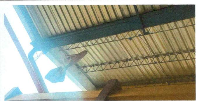
Foto 10 canales y bajadas de agua pluvial
