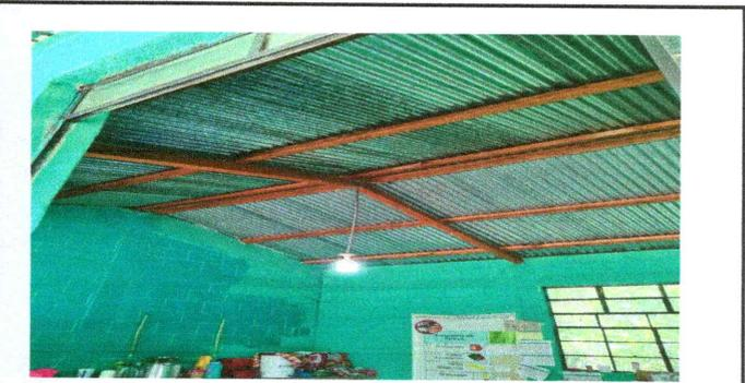
Foto 6: SOPORTE DE MADERA Y LÁMINA EN MALESTADO, VENTANAS EN MAL ESTADO
