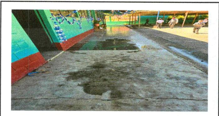
Foto 3: PISO CON GRIETAS Y LEVANTADO
