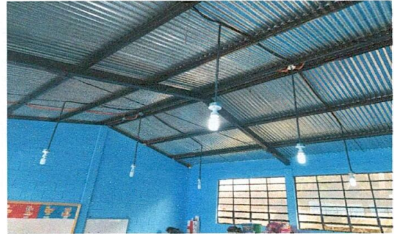
Foto 4: Sustitución de focos ahorradores
