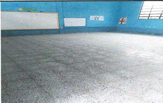
Foto 5: Sustitución de piso de granito
