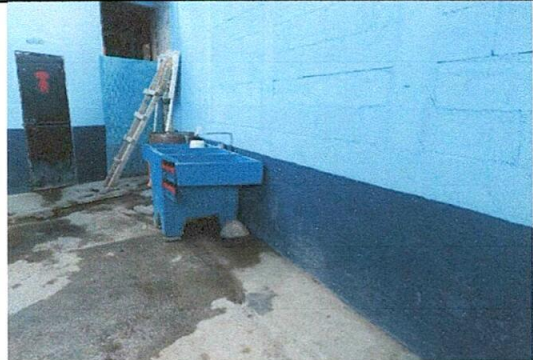
Foto 6: Sustitución de pila
