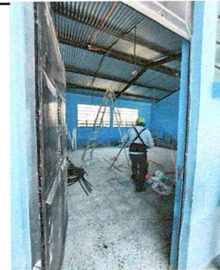
Foto 4: Sustitución de focos ahorradores
