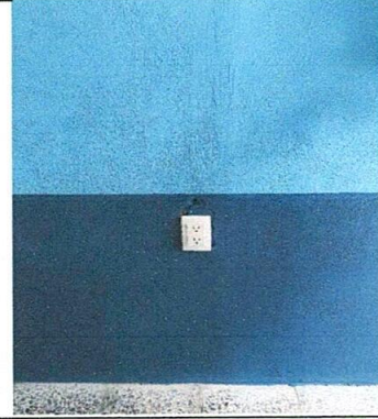
Foto 2: Sustitución de toma corrientes
