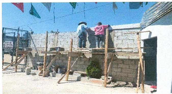
Foto 3: Reparación de muro perimetral
