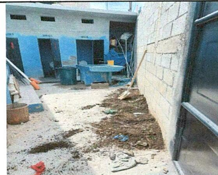
Foto 6: Sustitución de pila
