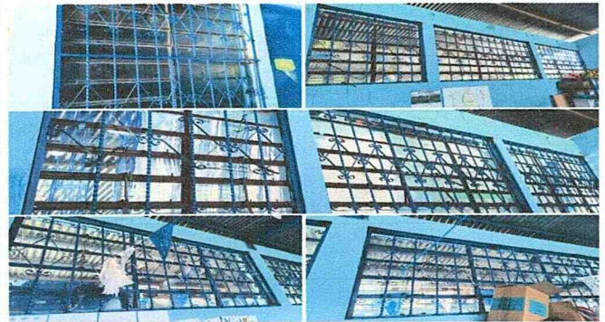
Foto 4: Sustitución de balcones
