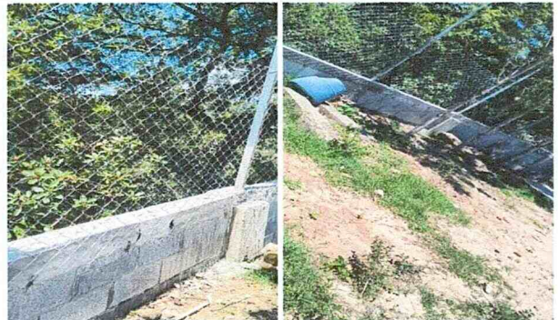
Foto 2: Reforzamiento de muro de contención
