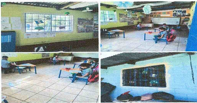
Foto 5: Sustitución de piso cerámico
