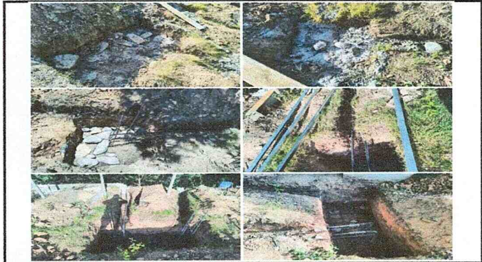
Foto1: Reforzamiento de muro de contención
