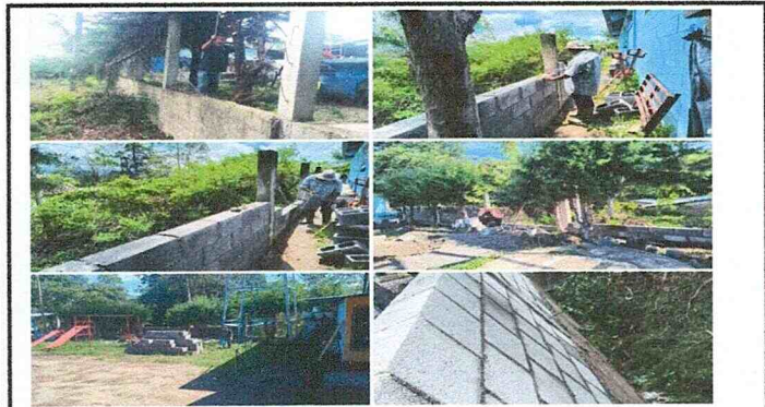
Foto 3: Mejoramiento de muro perimetral
