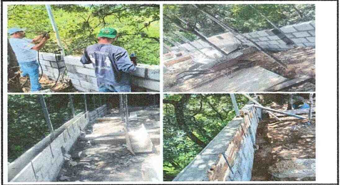
Foto 2: Reforzamiento de muro de contención
