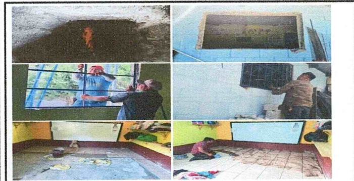
Foto 5: Sustitución de piso cerámico
