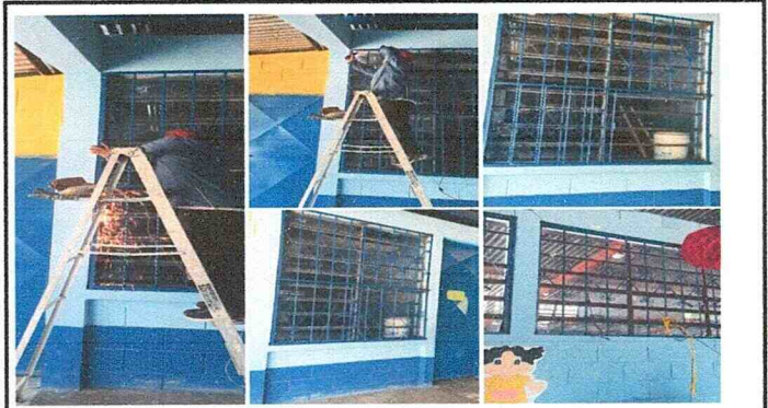
Foto 4: Sustitución de balcones
