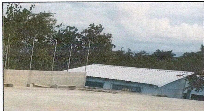
FOTO 3: MEJORAMIENTO DE CANCHA, A TRAVÉS DE LA FUNDICIÓN DE MURO DE CONTENCIÓN
