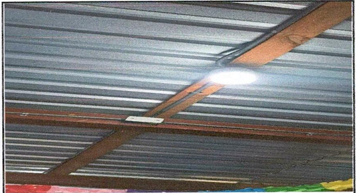
FOTO 4: SUSTITUCIÓN DE CABLEADO Y ACCESORIOS ELÉCTRICOS
