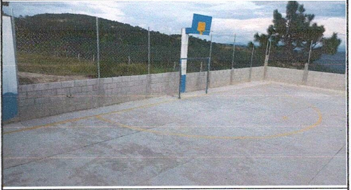
FOTO 2: CONSTRUCCIÓN DE MURO PERIMETRAL CON 5 HILADAS DE BLOCK, TUBO GALVANIZADO FUNDIDO Y MALLA
