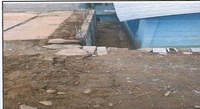
FOTO 3: CONSTRUCCIÓN DE MURO DE CONTENCIÓN PARA MEJORAMIENTO DE CANCHA
