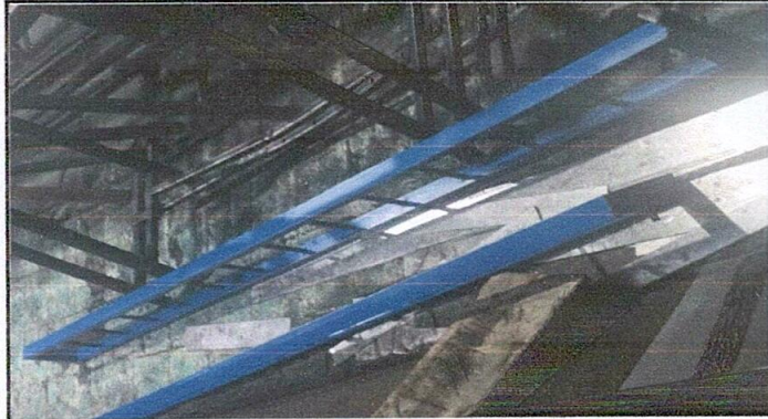
FOTO 1: FABRICACIÓN DE REJA DE SEGURIDAD PARA COLOCAR EN PARED
