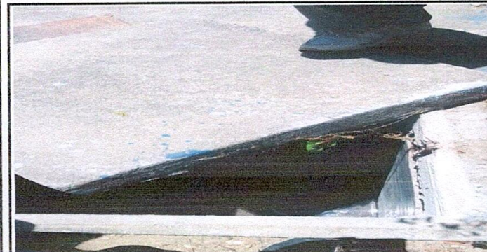
FOTO 5: CAMBIO DE TAPA DE CISTERNA DE AGUA PARA COLOCAR UN DEPÓSITO DE ALMACENAMIENTO DE AGUA
