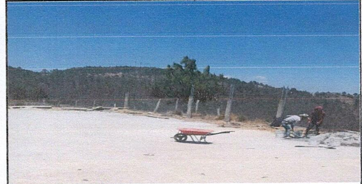
FOTO 6: REALIZACIÓN DE TRABAJOS PARA CONSTRUCCIÓN DE ACERA
