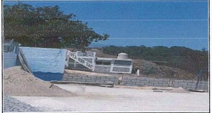
FOTO 2: CONSTRUCCIÓN DE 5 HILADAS DE BLOCK PARA REALIZACIÓN DE MURO PERIMETRAL
