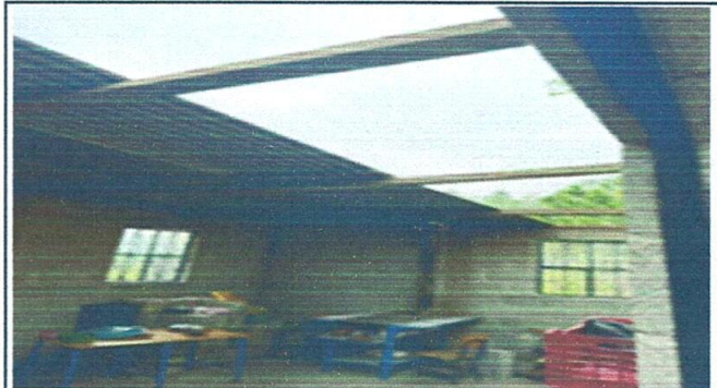
Foto 2: REPARACION DE TECHO
